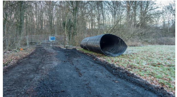
Ausbau des Weges im Bereich der binsen- und seggenreichen Nasswiese südlich des Beverbaches
