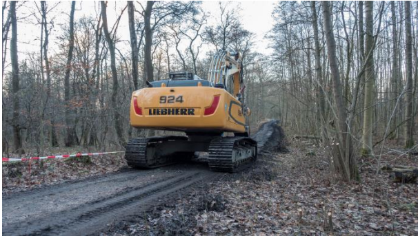
Beginn Abriss der Beverbachbrücke
