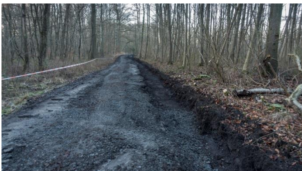
Wegeausbau südlich der ehemaligen Bücke
